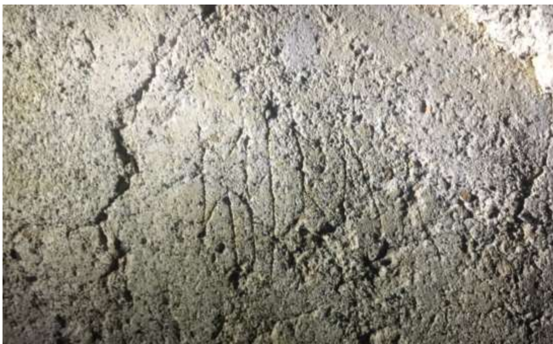
Fig. 24. Runristning i kalkbruket i uppgången till spiraltrappan (klotter från byggnadstiden?), preliminär läsning och förslag till tolkning: starui , fvn. starfi 'tungt arbete'.
