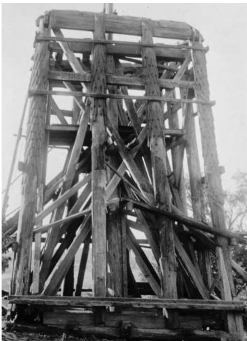
Fig. 22. Trönöstapeln från norr under restaurering 1914, med takkonstruktionen demonterad.
