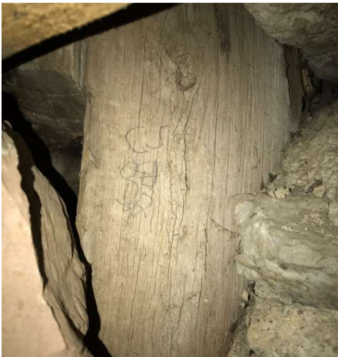
Fig. 17. Stolpen norr om mitten i västra muren sedd från spiraltrappan, med urtag för tapp. Den moderna bjälken upptill är en del av underlaget till det nuvarande trägolvet ovanpå murkrönet.
