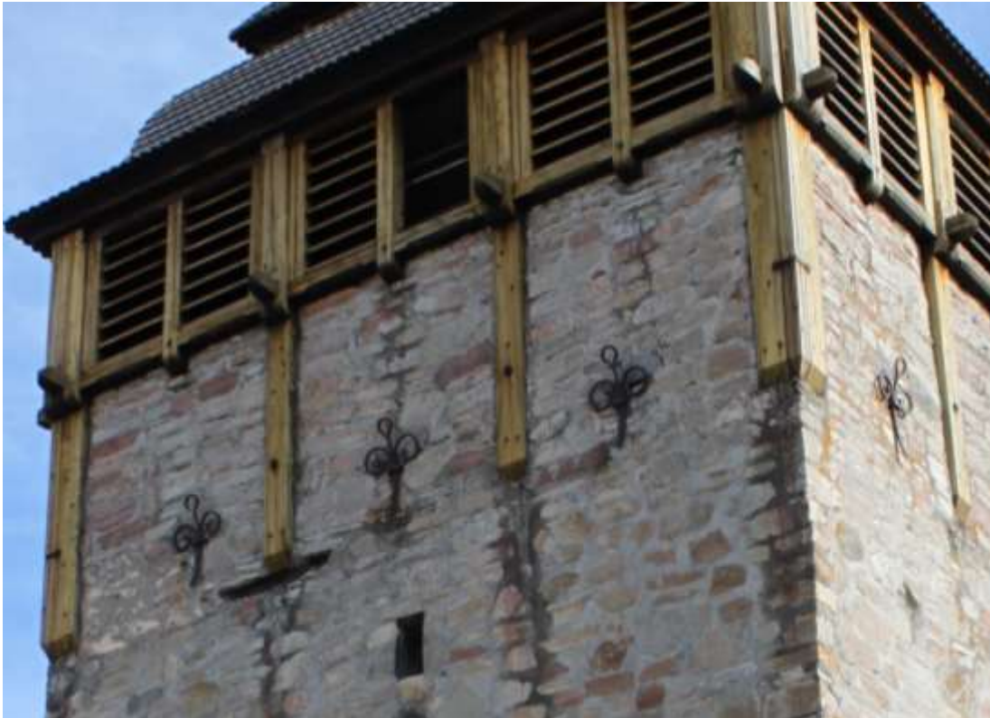
Fig. 1. Plankorna som vid 1896–97 års restaurering monterats utanpå de i murarna infällda, medeltida stolparna. Södra fasaden. Notera den inmurade, horisontella bjälken som skymtar nedanför en av plankorna. Foto: Jamtli, 2010.
