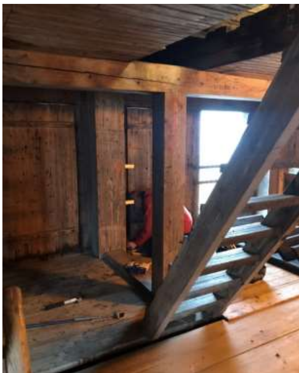
Fig. 3. Panelbrädor lossas runt stolpen söder om mitten i västra muren.
