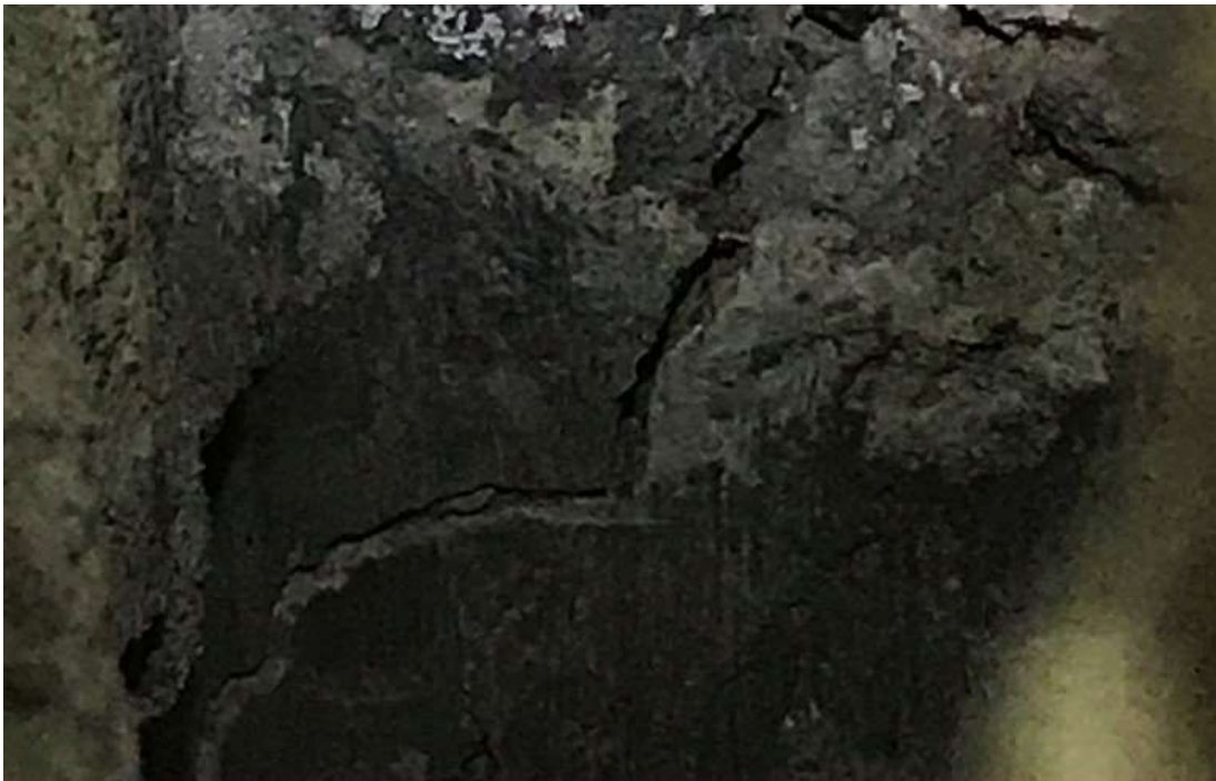
Fig. 20. Detalj av föregående bild. Notera avtrycken av den ursprungliga stolpens årsringar i kalkbruket.
