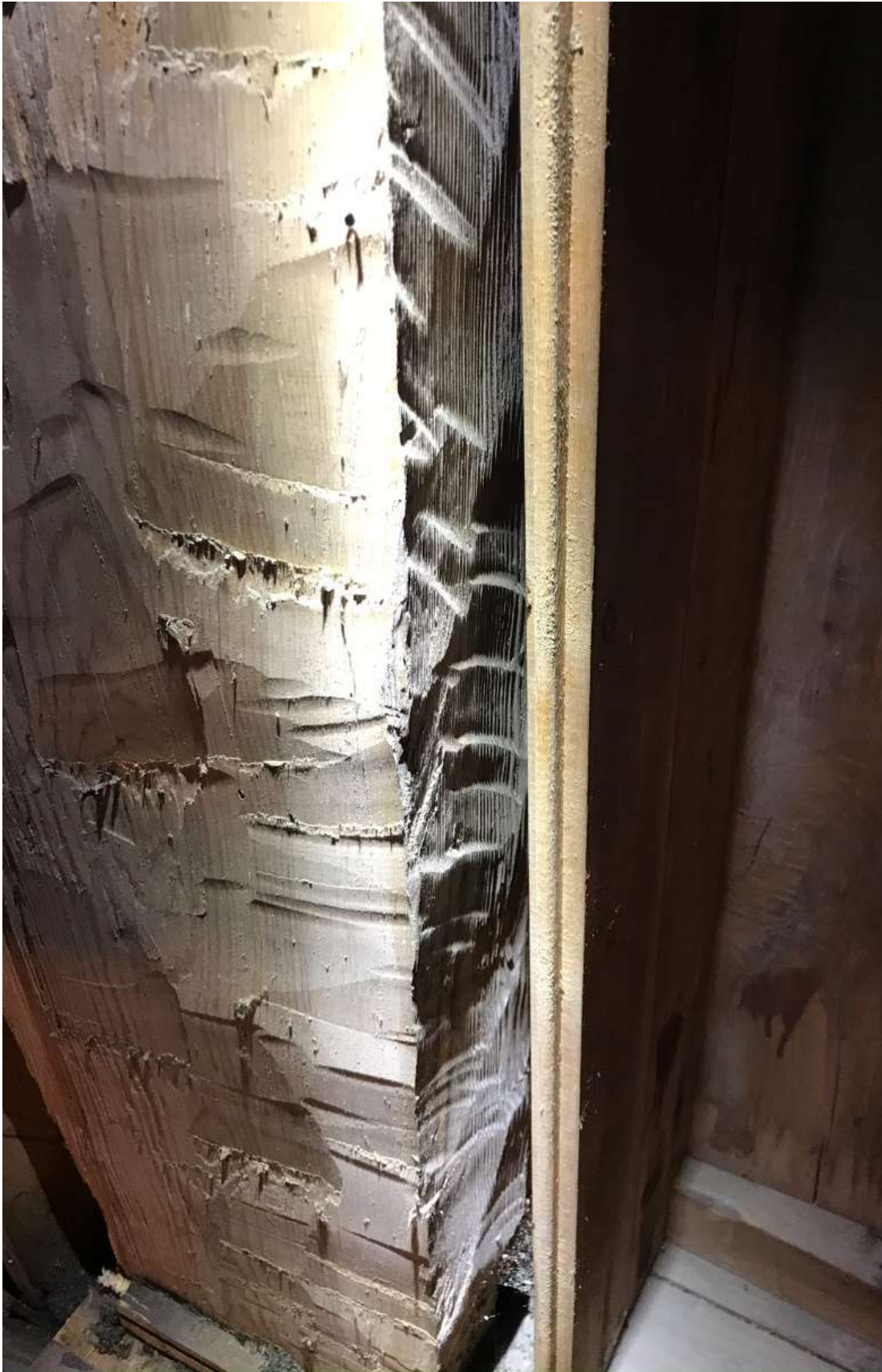
Fig. 5. Spår av sprättäljning på norra sidan av samma stolpe. Insidan av stolpen är nybuggen.
