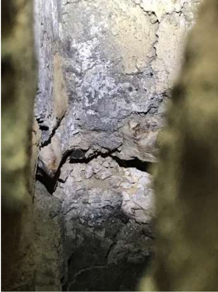
Fig. 19. Hålighet i muren efter den ursprungliga stolpen norr om mitten i västra muren.
