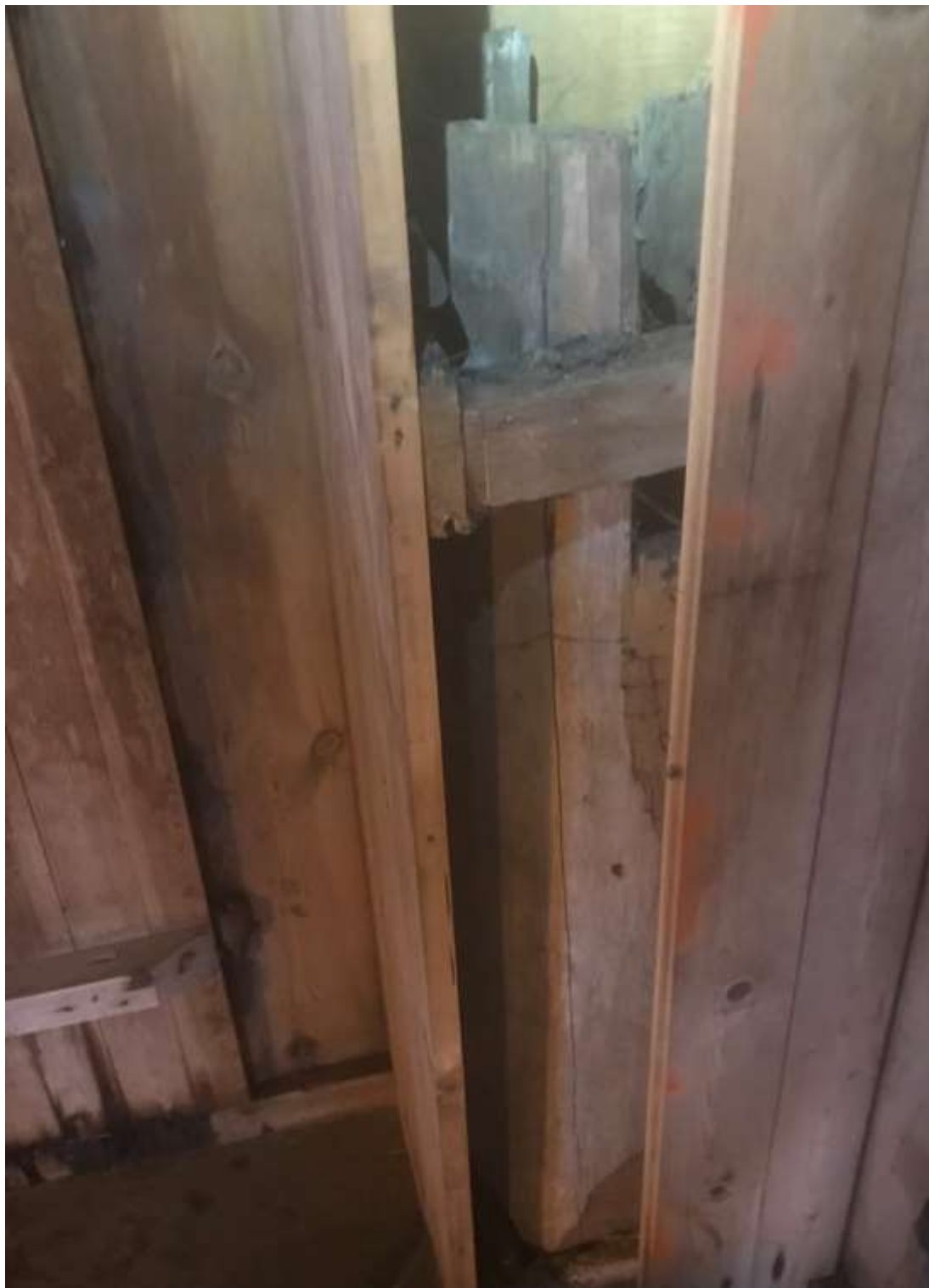
Fig. 16. Nordvästra hörnstolpen efter borrprovtagning (prov 3).
