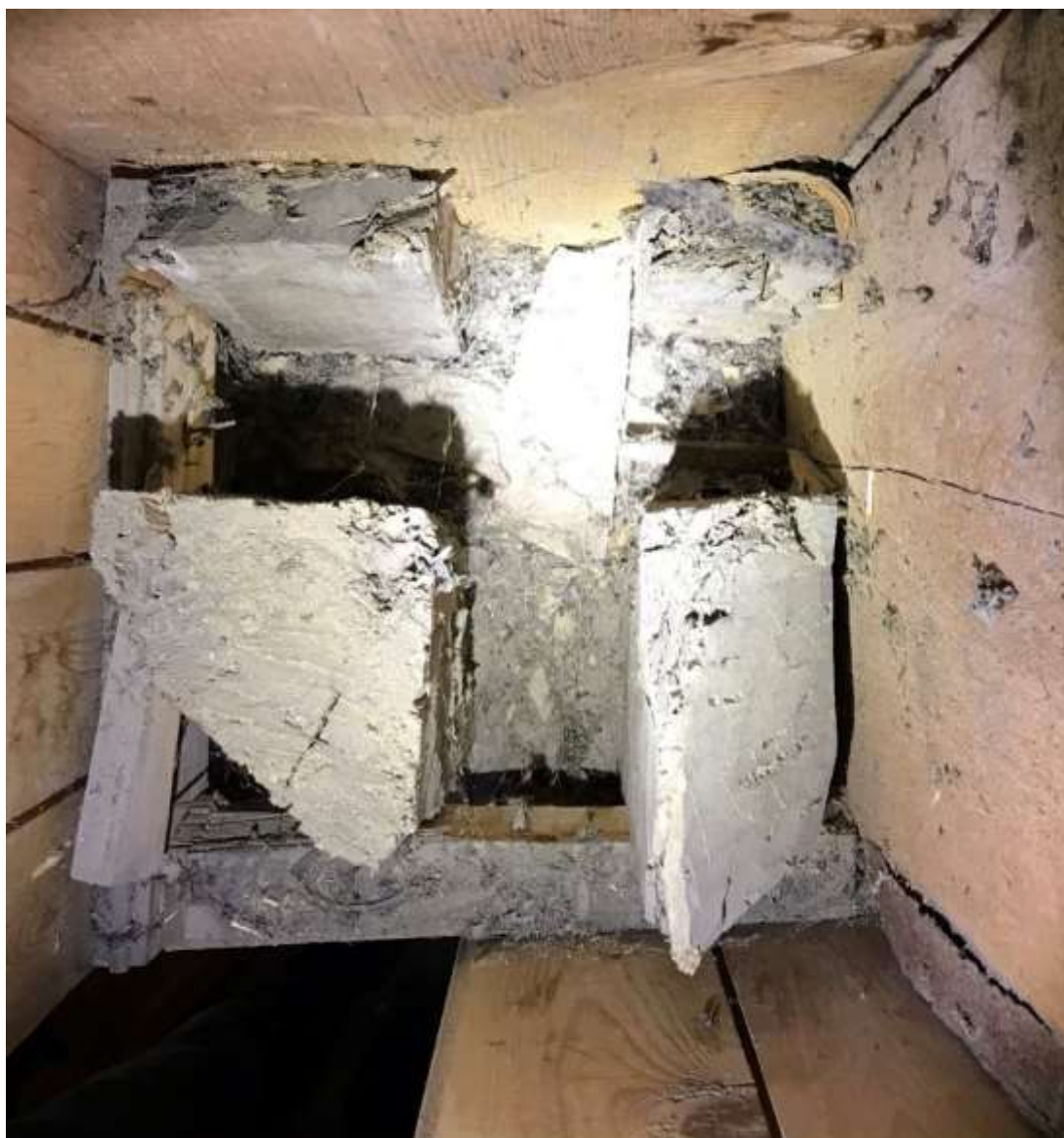
Fig. 13. Urtagen i toppen av nordvästra hörnstolpen.
