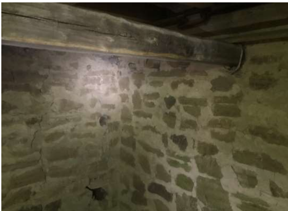
Fig. 23. Bevarad bjälke och stumpar efter avsågade bjälkar strax under den nuvarande klockstolen i tornet.
