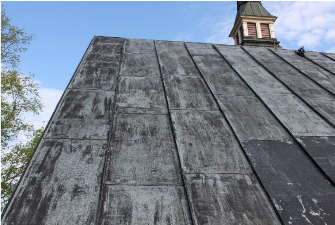
Figur 3. Takfall mot sydväst (västra korsarmen) efter blästring.
