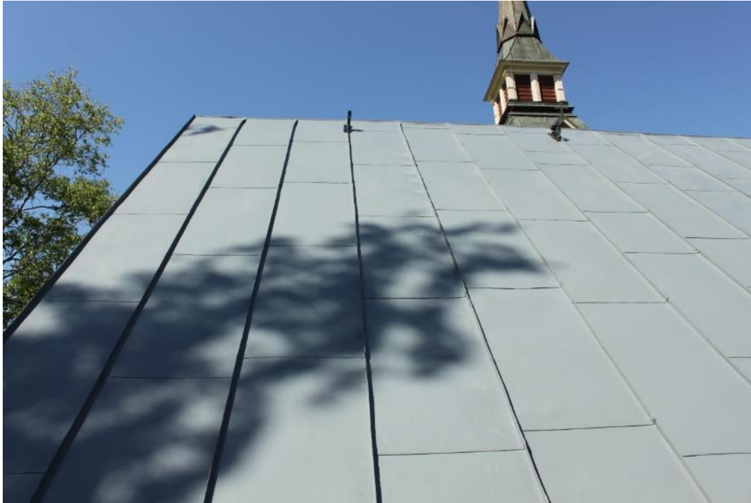
Figur 4. Takfall mot sydväst (västra korsarmen) sedan taket grundats.
