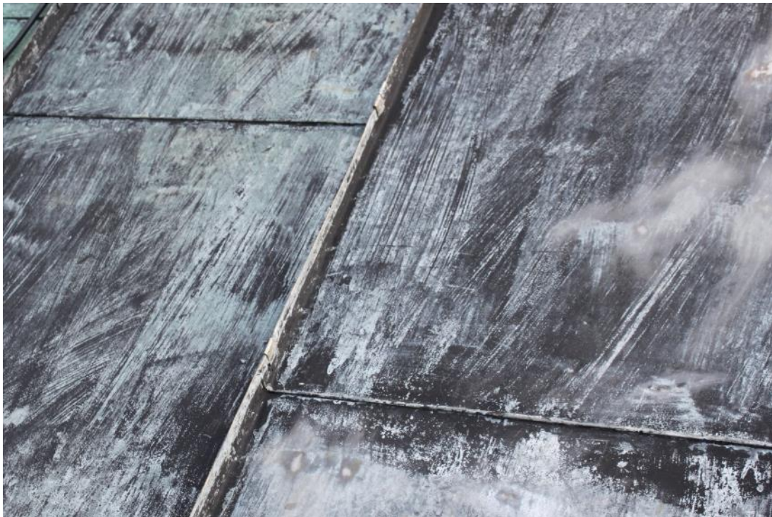
Figur 7. Falsar som satt löst har tryckts till (bild tagen sedan taket blåstrats).
