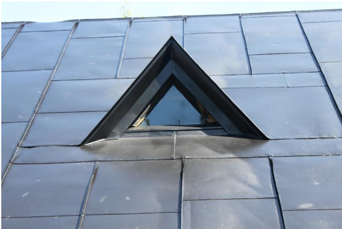
Figur 9. Plåten har tryckts ned och fästs med klammer.
