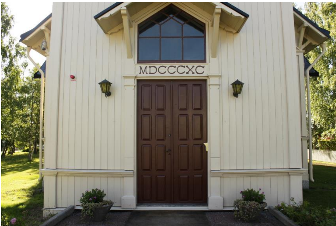
Figur 13 Under sommaren 2020 har entrédörrarna åtgärdats och målats med samma färg som 2019.
