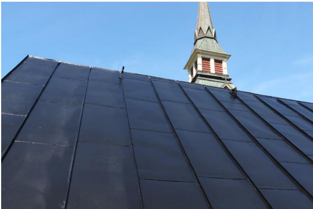
Figur 5. Takfall mot sydväst (västra korsarmen) efter att taket målats.
