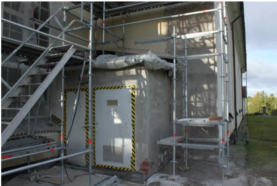
Figur 13 Lits kyrka 2018-09-13 efter att den bilade ytan försetts med nytt putslager.
