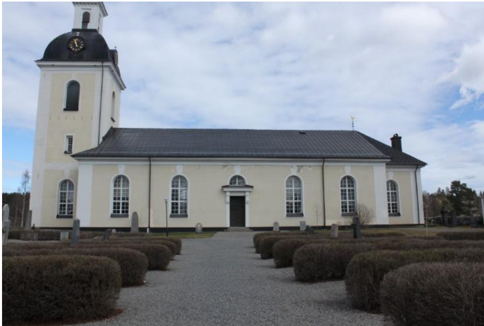
Figur 2 Lits kyrka 2018-05-07, södra fasaden före åtgärd.
