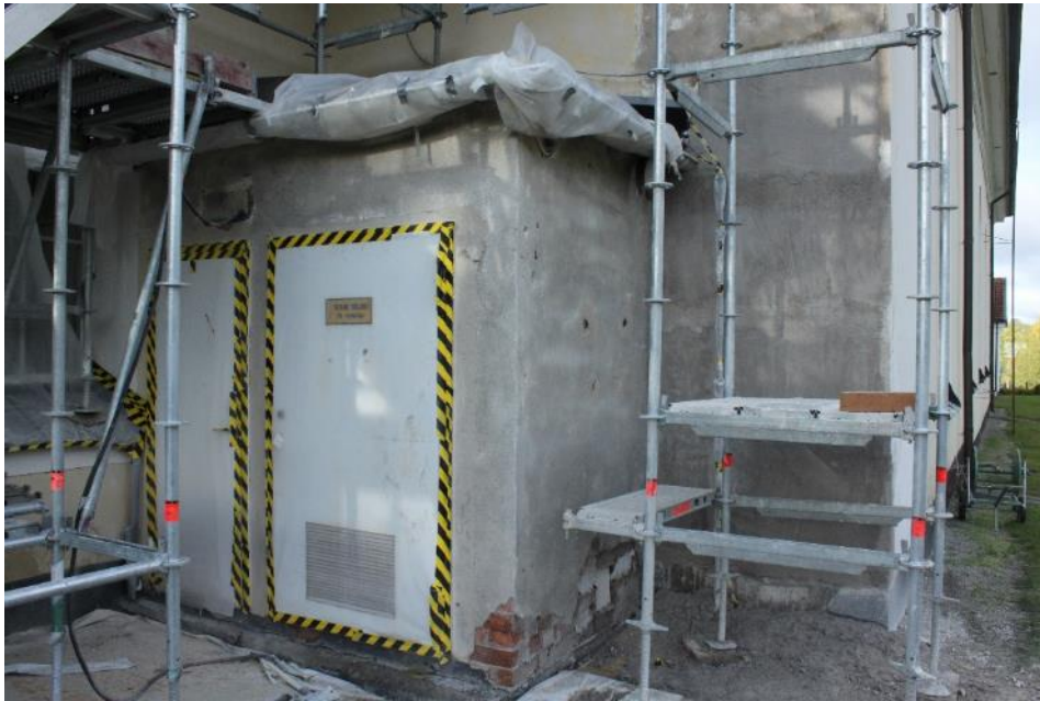
Figur 28 Lits kyrka 2018-09-13 Transformatorhus efter blästring.
