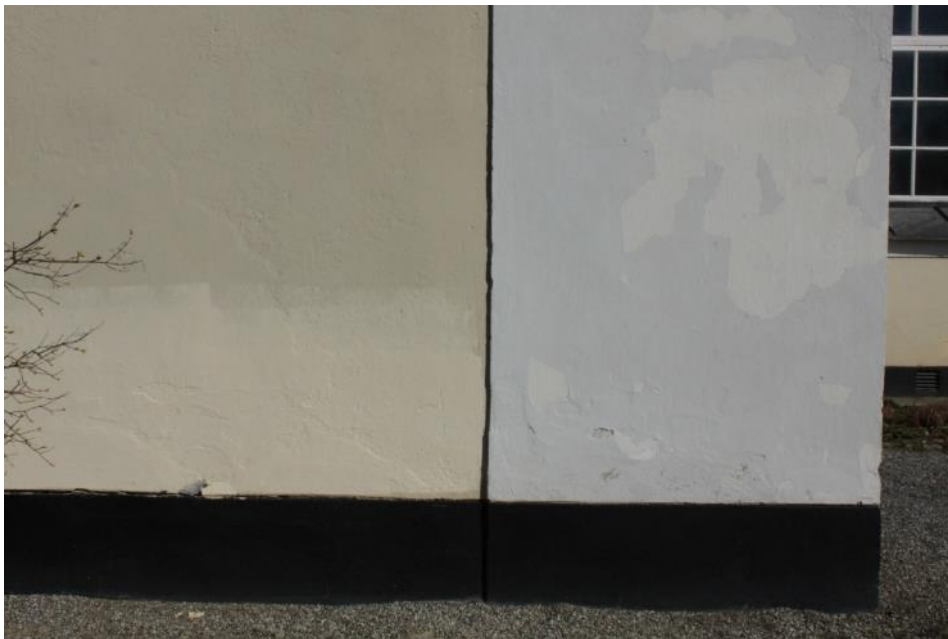
Figur 5 Lits kyrka, södra fasaden 2018-05-07 Färgbortfall på hörnlisen. Tidigare bättringsmålning med något avvikande kulör på det gula väggfältet.
