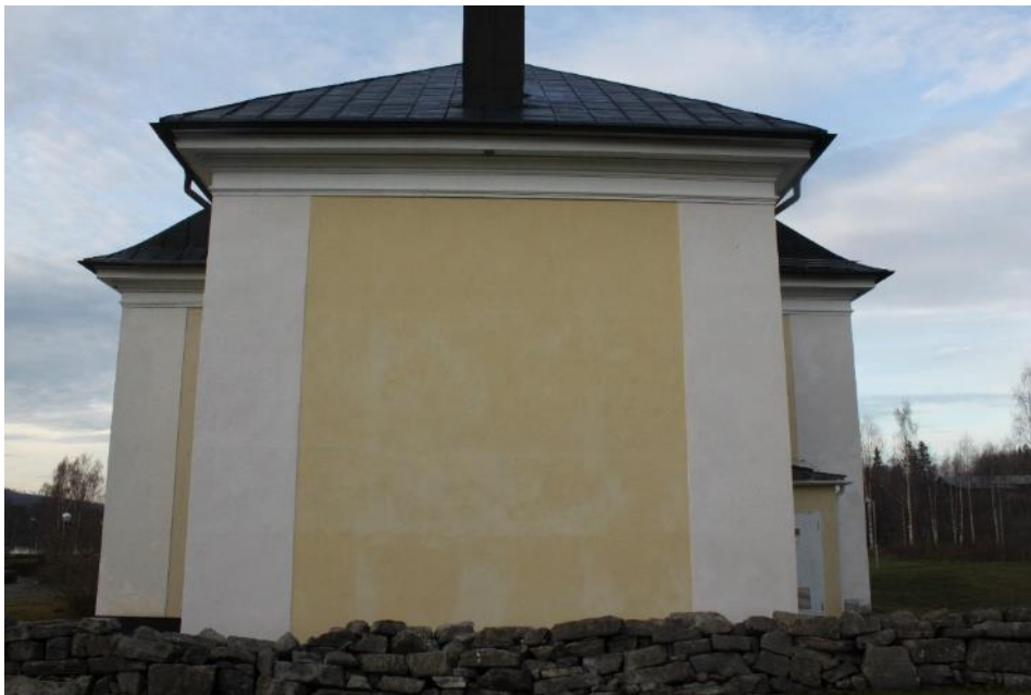
Figur 22 Lits kyrka 2018-11-05 Då putsen fortfarande var relativt fuktig, syntes tydligt vilken del av fasaden som fått beläggningen förnyad.
