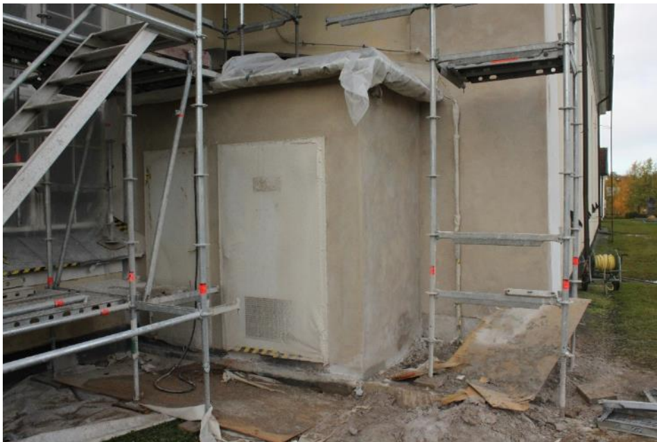
Figur 29 Lits kyrka 2018-09-26 Transformatorhuset sedan det försetts med en tunn ytputs.
