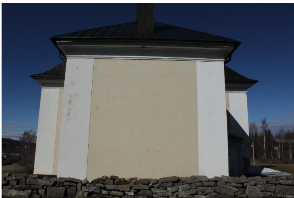
Figur 16 Lits kyrka 2018-05-07 Östra väggen på sakristian före åtgärd.
