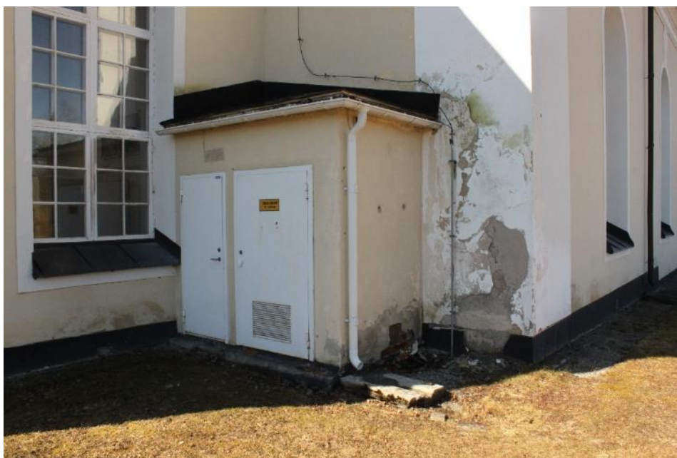
Figur 25 Lits kyrka 2018-05-07 Transformatorhus före åtgärd.
