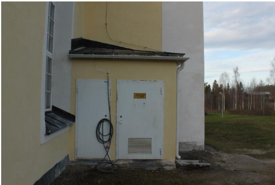
Figur 15 Lits kyrka 2018-11-05 Östra gaveln på långhuset efter åtgärd. Notera att sockeln inte åtgärdats ännu.
