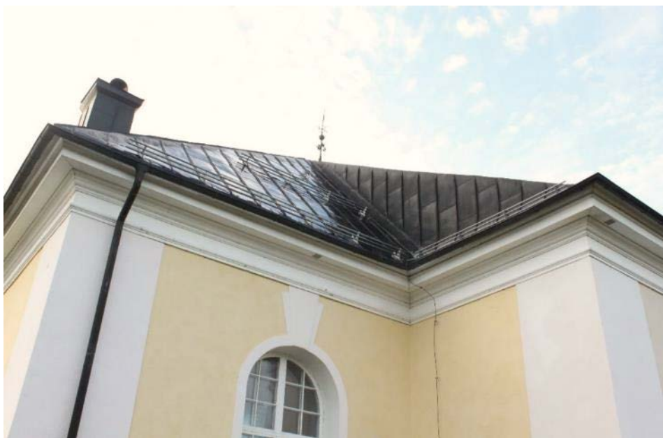
Figur 33 Lits kyrka 2018-11-05 Ovanför transformatorhuset har man, på kyrkans tak satt upp tre stycken snörasskydd (två på norra takfallet och ett på östra takfallet).
