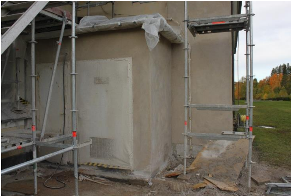
Figur 14 Lits kyrka 2018-09-26 efter att ytan försetts med ny ytputs.
