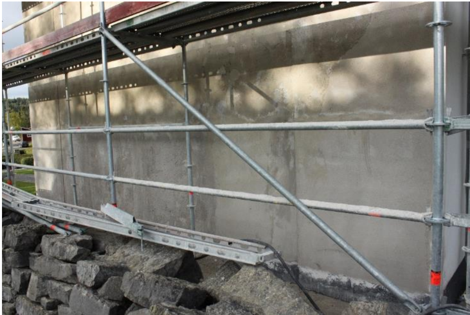
Figur 18 Lits kyrka 2018-09-13 efter att den bilade ytan försetts med nytt putslager.
