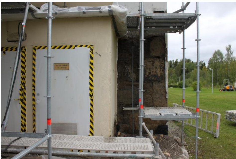
Figur 11 Lits kyrka 2018-08-29 Östra gaveln på långhuset efter att all puts bilats bort.
