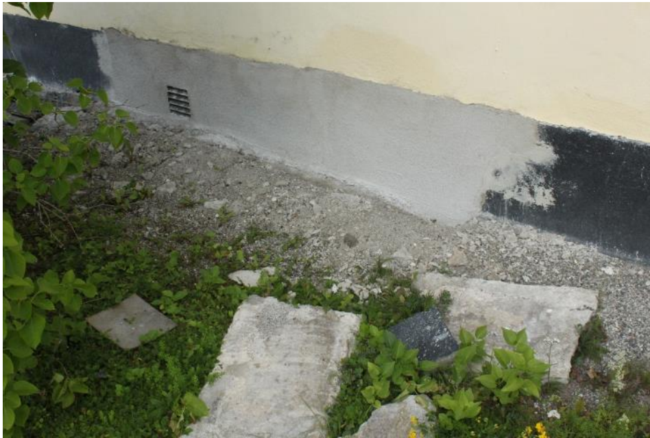
Figur 35 Lits kyrka 2019-08-19 Sockeln på södra sidan av långhuset sedan skadorna lagats.
