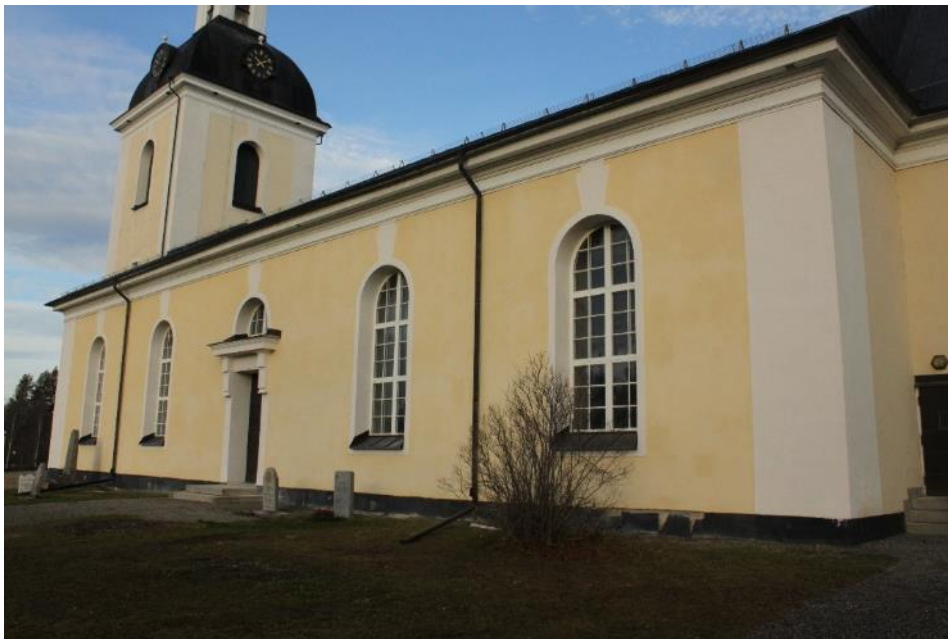
Figur 9 Lits kyrka 2018-11-05 Södra fasaden efter åtgärd.
