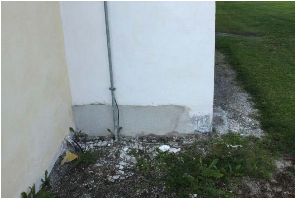
Figur 36 Lits kyrka 2019-08-19 Lagning av sockel i mötet mellan långhuset och transformatorhus.
