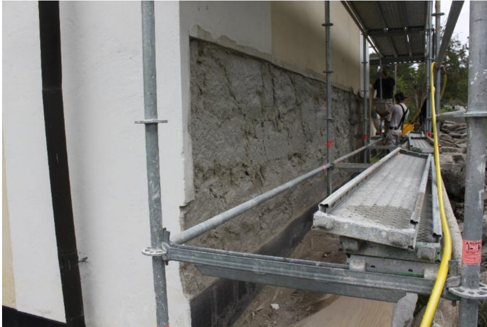
Figur 17 Lits kyrka 2018-08-29 Östra väggen efter att all puts bilats bort till en höjd av 1,5 m över sockelmarkeringen och muren grundats.
