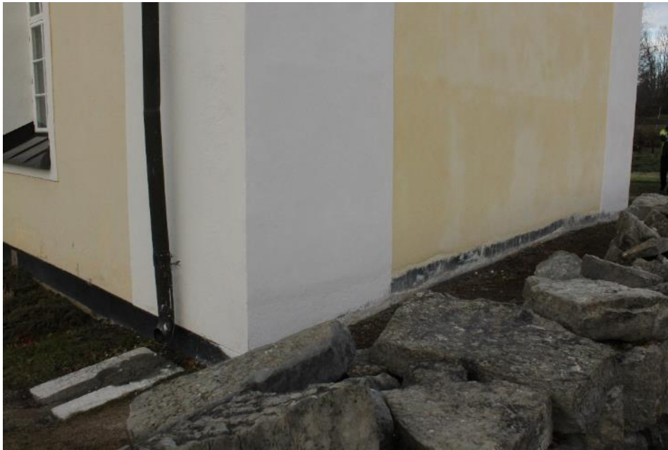
Figur 21 Lits kyrka 2018-11-05 Östra väggen på sakristian efter åtgärd.
