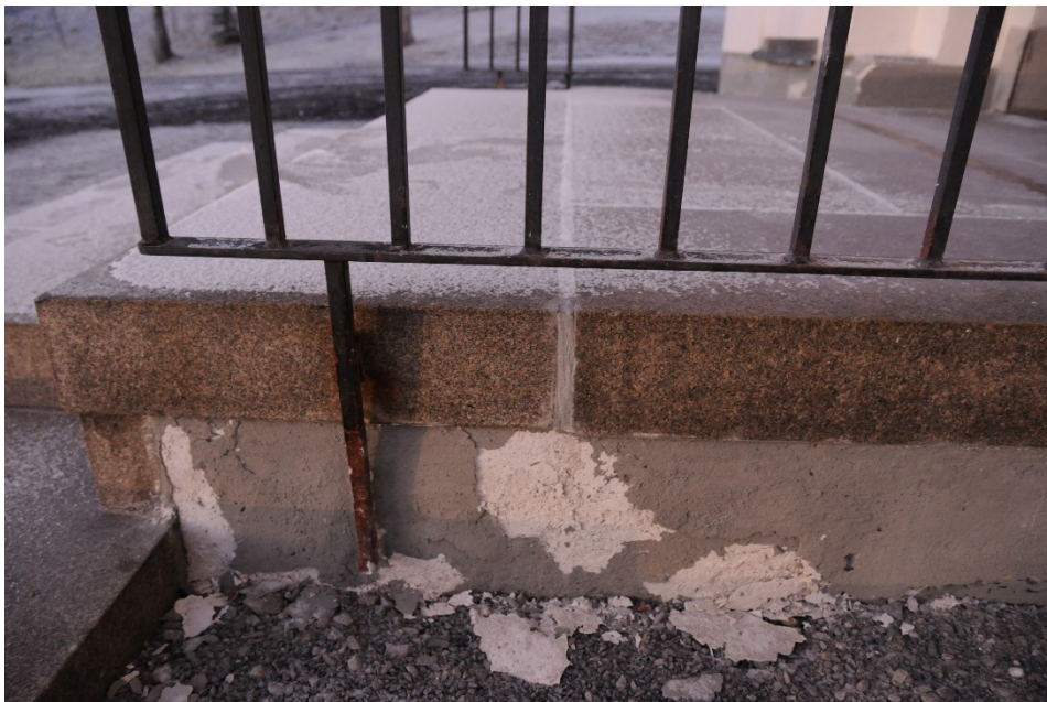
Figur 23 Trappans sidor målades en gång som skydd för putsen inför vintern. 2018-11-22 hade delar av färgen ramlat bort. Detta kommer att åtgärdas till våren 2019. Foto: Björn Olofsson.
