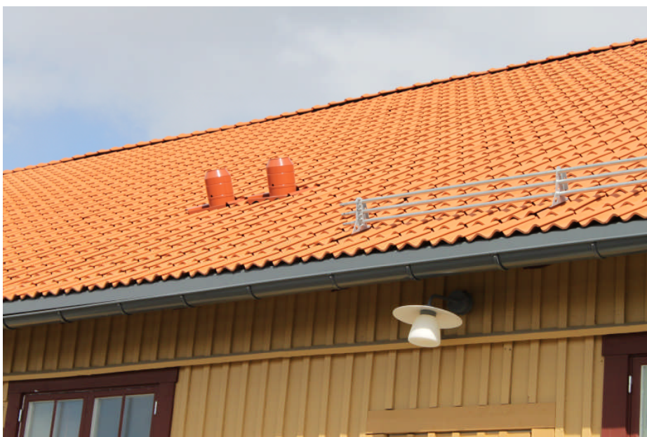
Mindre huvar har monterats på taket
