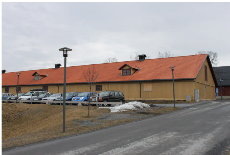
Fasad mot väster före det att takfönster tas upp
