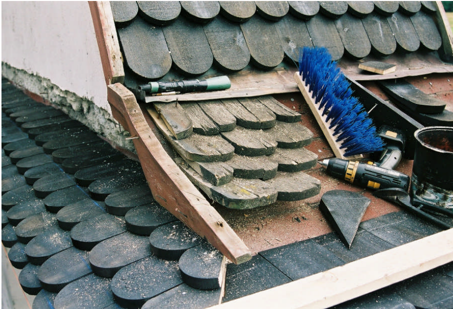
Ett parti av äldre spån håller på demonteras, övriga delar består av nytt spån Jlm 06m68_27
