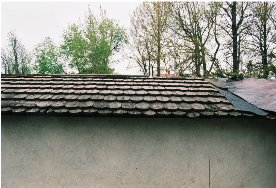
Bogårdsmurens tak innan befintligt spån rivs bort
