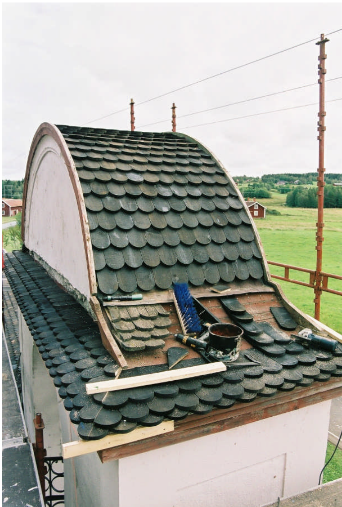
Arbete pågår med spånläggning på en av stigportarna Jlm 06m68_26
