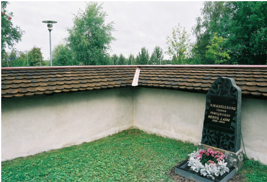
Spänläggningen är klar, spänen har tjarats
