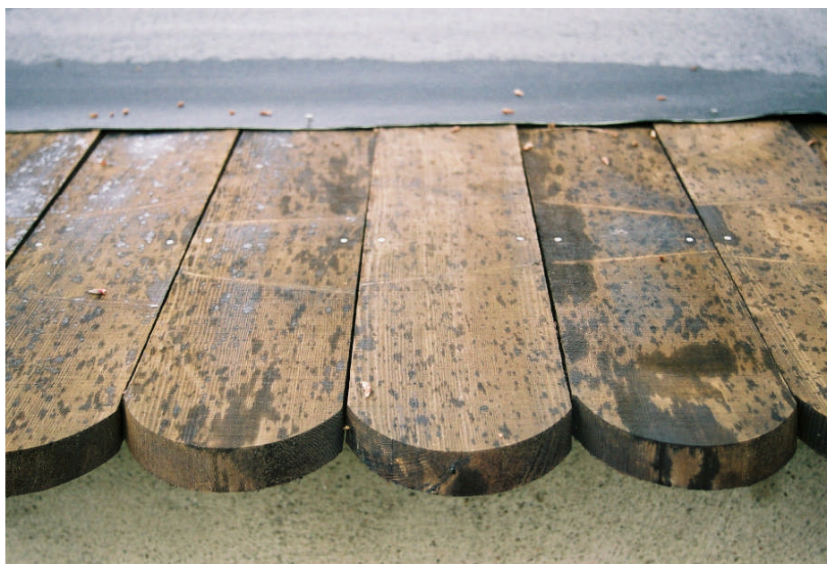
Nya spån, här syns att de spikats med två spik per spån
