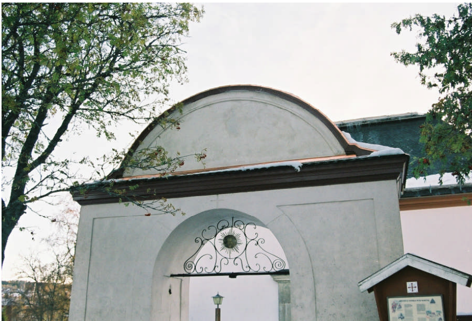
Här syns den nya kopparavtäckningen vid den västra stigporten
