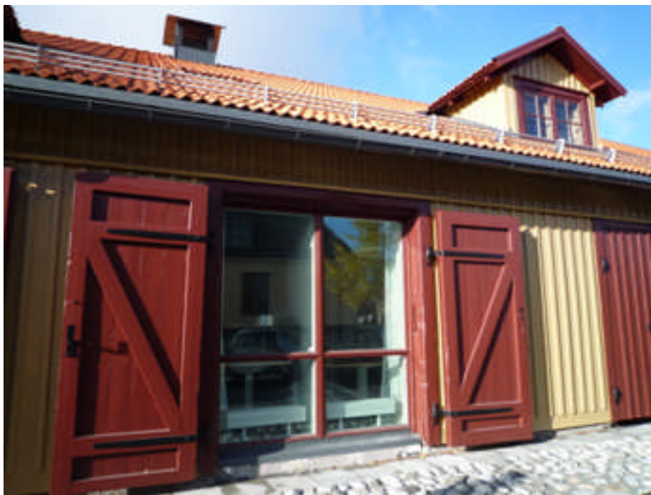
Bild 5. I de gamla portöppningarna på den östra fasaden har nya glaspartier satts in (digital bild nr 1020542).
