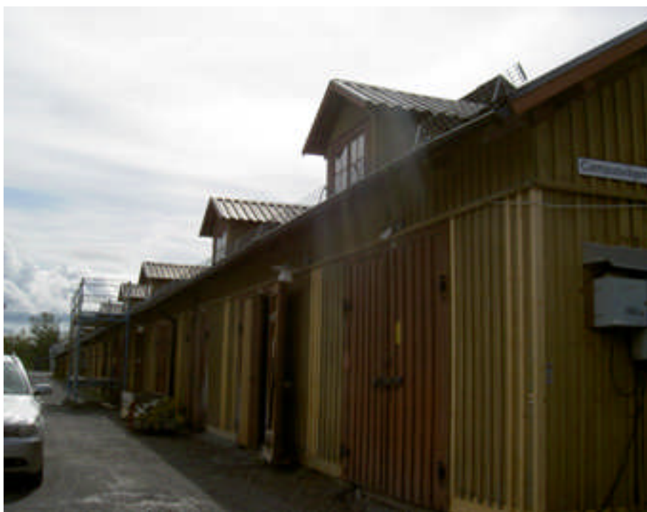
Bild 1. Byggnad 33 efter att renoveringen påbörjats 2008 (digital bild nr 014).
