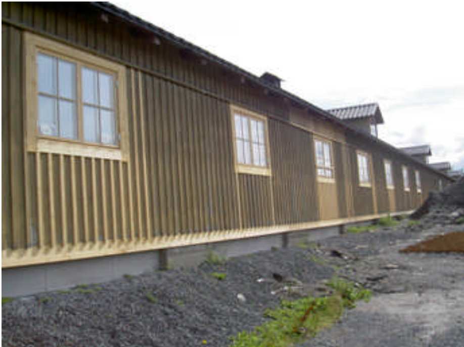
Bild 2. Rötskadade panelbräder och lister har bytts ut (digital bild nr 006).
