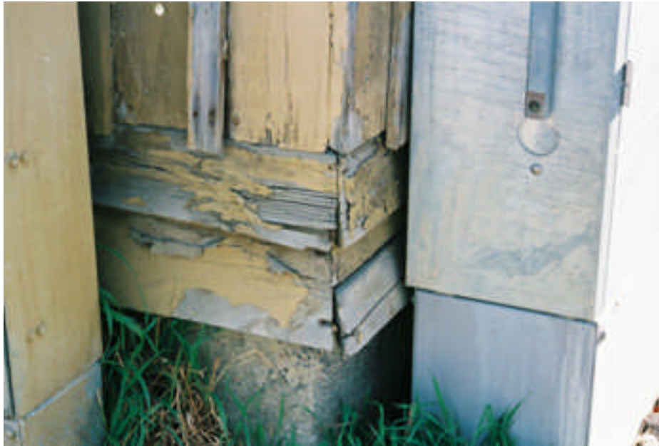
Bild 3. Sockellisterna var innan restaureringen satta på förvandring (bild nr 08m031/31).
