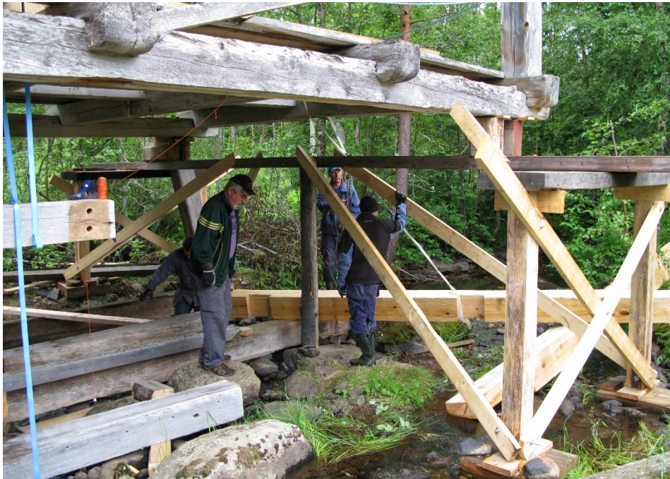
D-sylen är på gång att läggas på plats. Foto Stig Nilsson.
