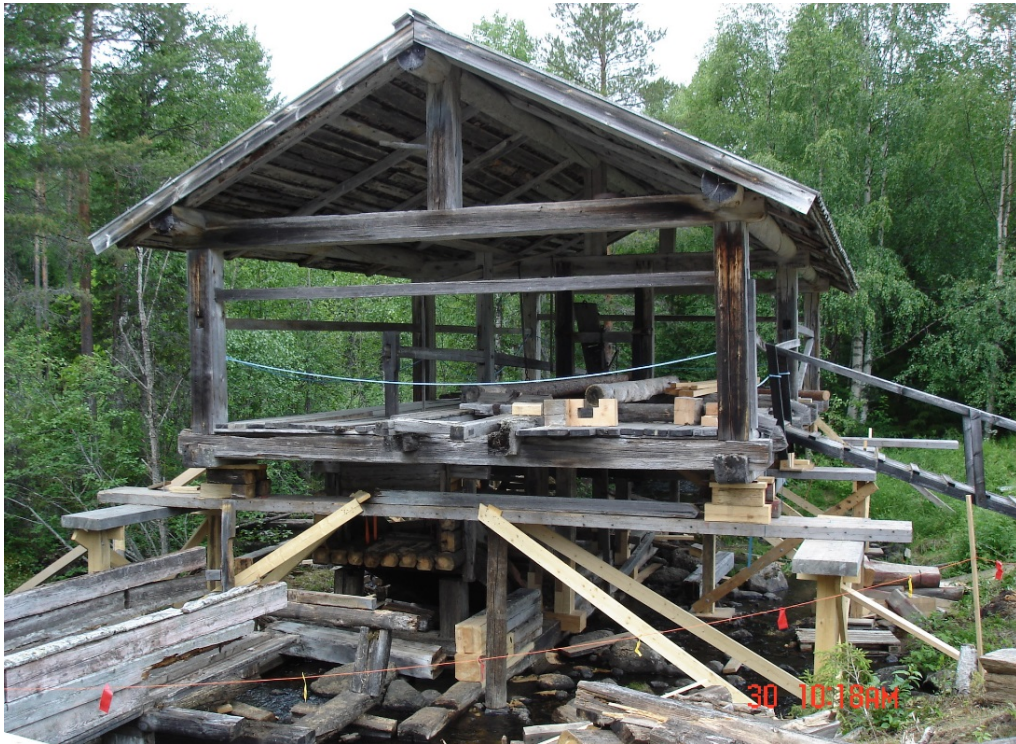
B-väggens syll har lyfts bort. Foto Stig Nilsson.
