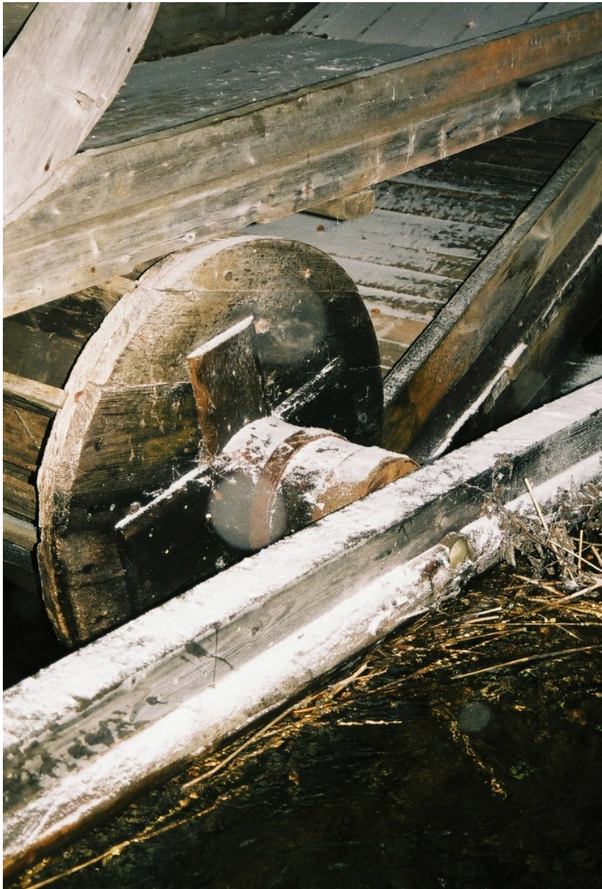
Vattenhjulets axel var fäst med ett järnrör som vilade på C-syllen. Bildnr: Jlm 06m84/36
