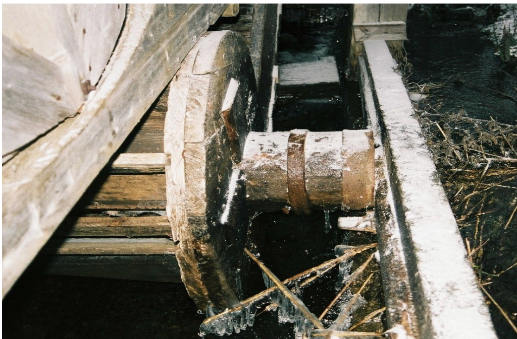
Axeln låg emot C- syllen. Bild nr: Jlm 06m84/37
