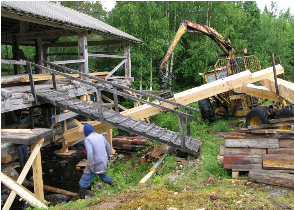
Färdigbilade syllstockar lyfts med kran ned till sågbyggnaden. Foto Stig Nilsson.
