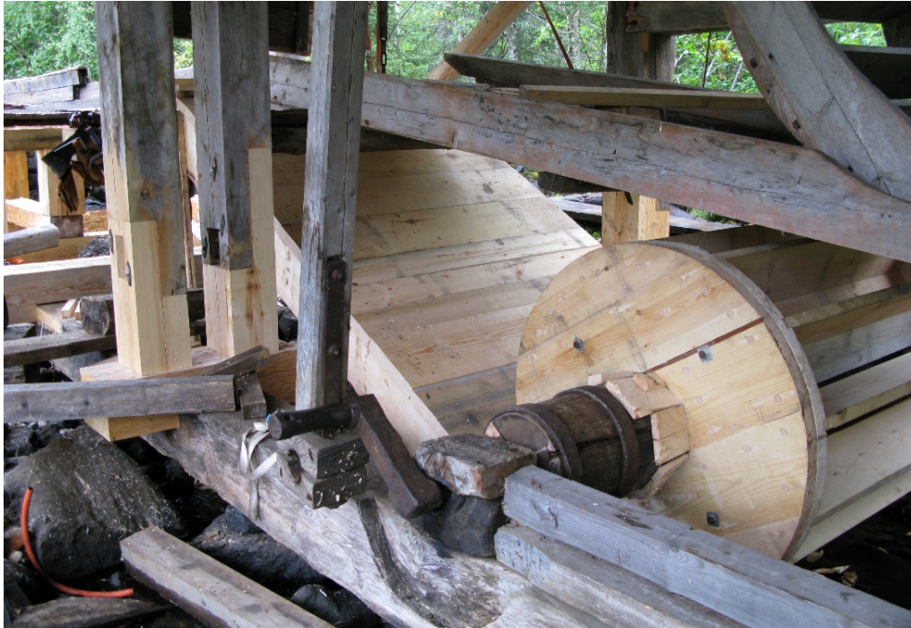
Det nya vattenhjulet på plats. Foto Stig Nilsson.
