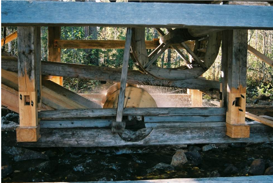
Stolpar vid bärlinan (E) har skarvats i nederkant och förstärkts med bultar. Bildnr: Jlm_08m48_19
