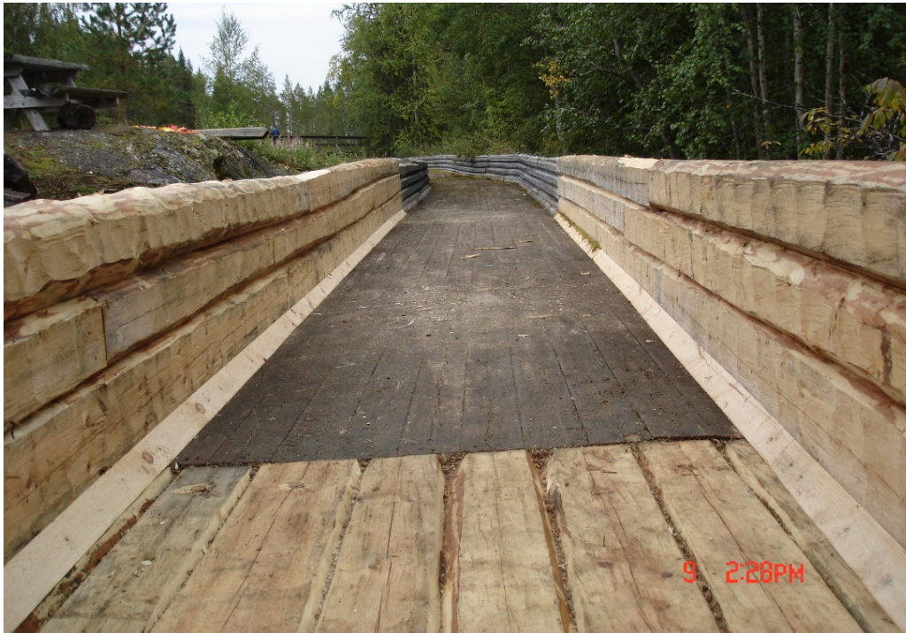
Bilden visar övergången mellan den nytimrade botten och den fortsatta botten av plank. Foto Stig Nilsson.
