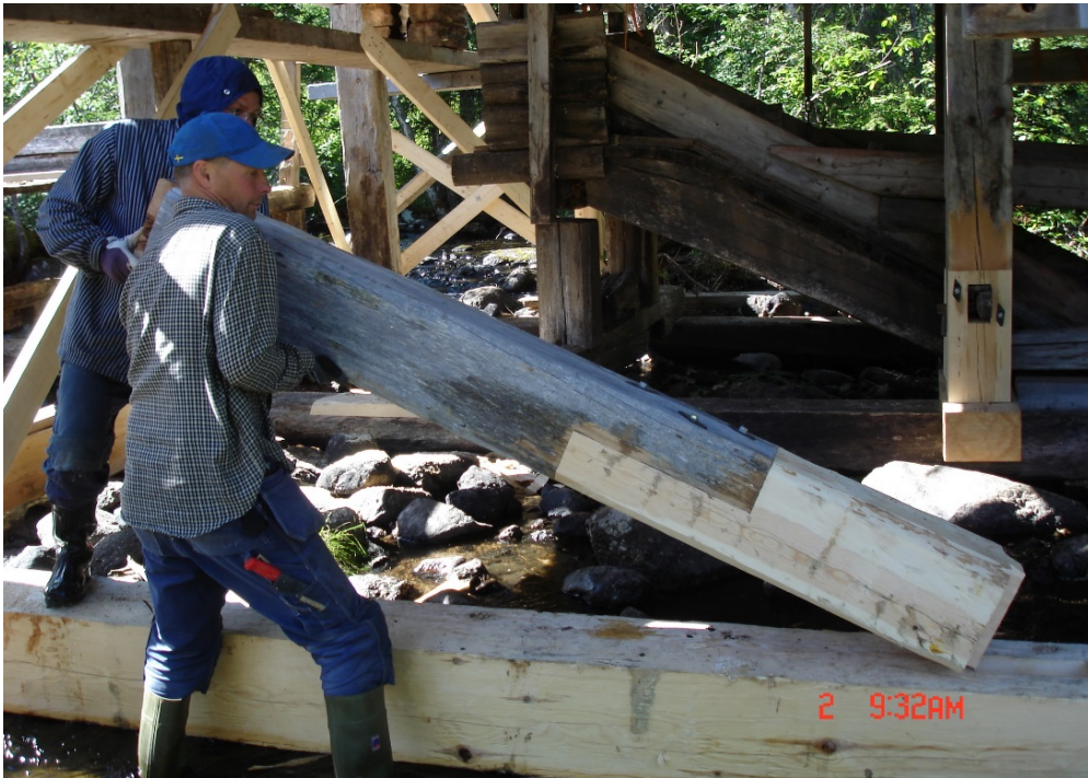
Stolpe på A-väggen på väg att resas upp och tappas in i urtaget i syllens överkant. Foto Stig Nilsson.
