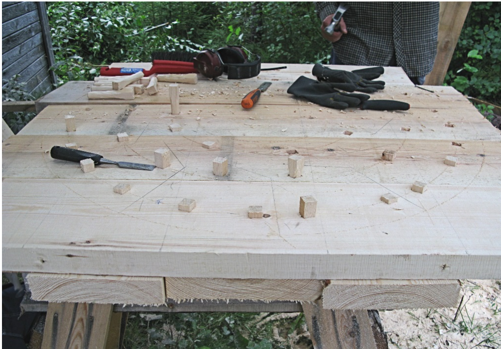
Gaveln till det nya vattenhjulet har tillverkats av tjocka korslagda brädor som fästs ihop med träpluggar. Foto Stig Nilsson.
