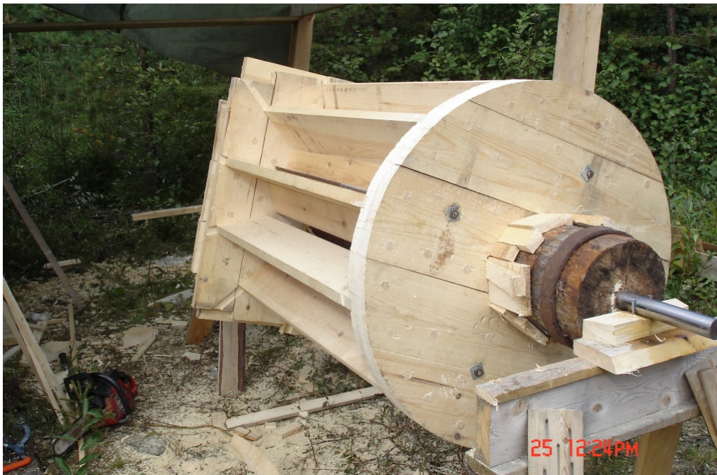
Skovlarna är på plats mellan vattenhjulets gavlar. Vevaxeln har monterats med ny axeltapp. Foto Stig Nilsson.
