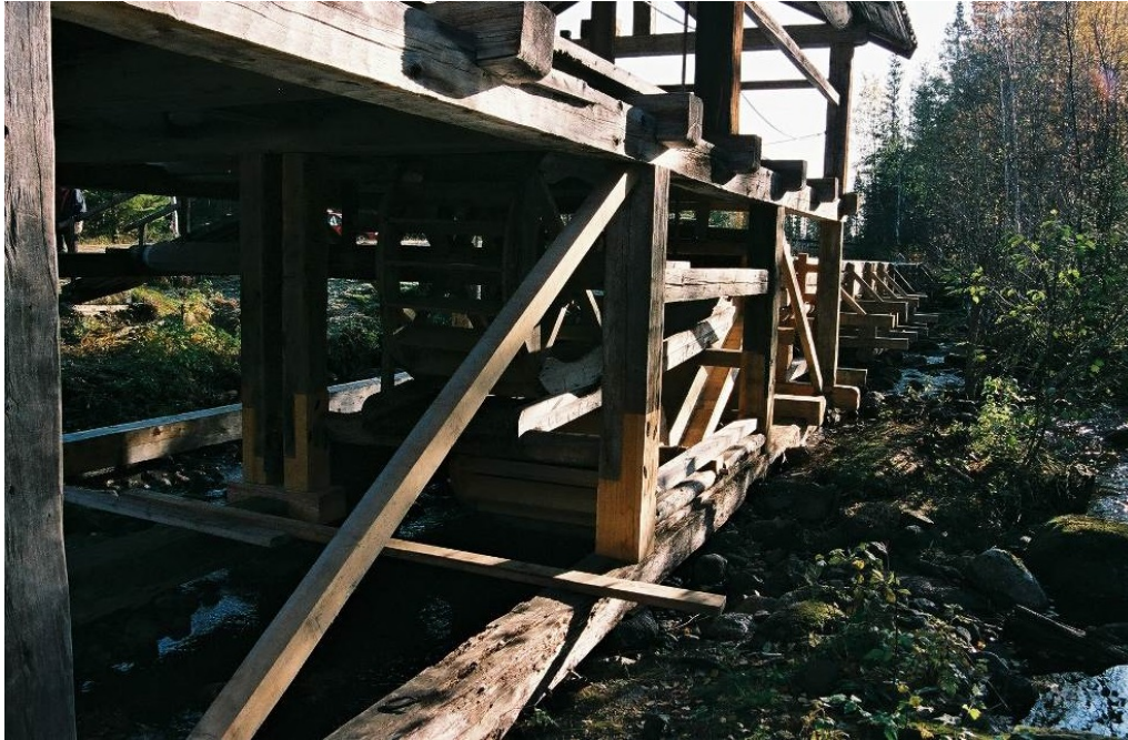
C-vägg, båda strävorna har bytts ut i sin helhet. Bildnr: Jlm_08m48_05
