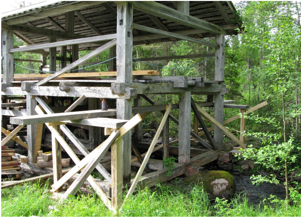
Bockryggar har byggts på vilka limträbalkar vilar. På limträbalkarna kom man sedan att sätta hydrauldomkrafter för att kunna lyfta sågbyggnadens övre plan. På så vis kunde man lösgöra stolparna på nedre våningen. Foto Stig Nilsson.
