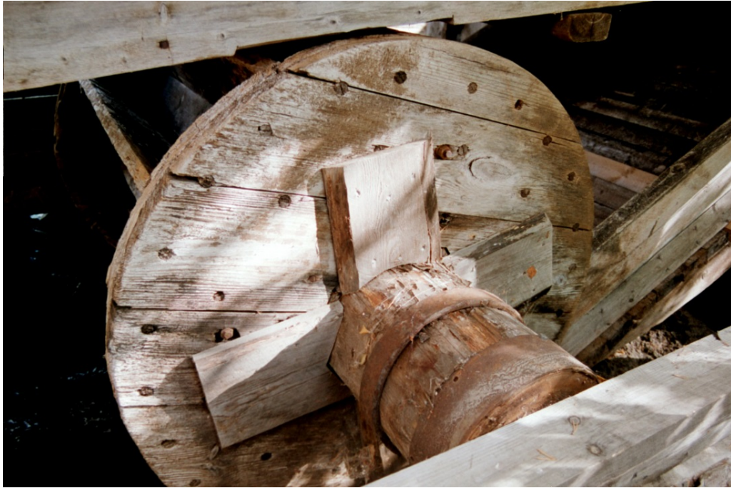
På vattenhjulets sidostycken hade brädbitar spikats fast för att stadga konstruktionen. Bildnr: Jlm 03m211.
