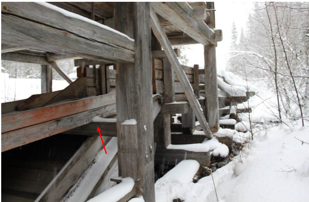
Den knäckta bärningen till övre vattenrännan har bytts ut. Pilen visar vilken balk som avses. Foto från 2015.
