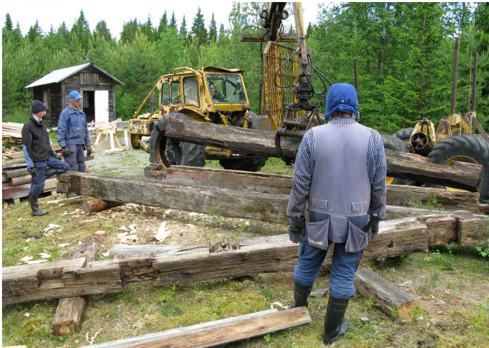
Rötskadade syllar har lyfts bort. Urtag och knutpunkter ”överfördes” till de nya syllarna. Foto Stig Nilsson.
