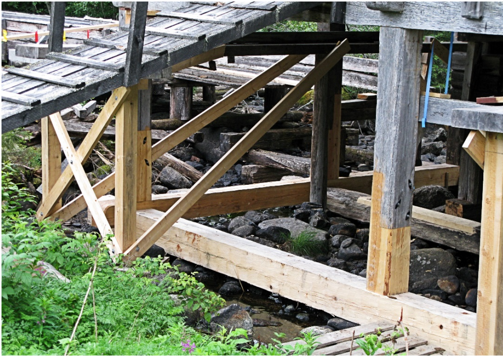
Skarvade stolpar på plats på A-vägg. Foto Stig Nilsson.
