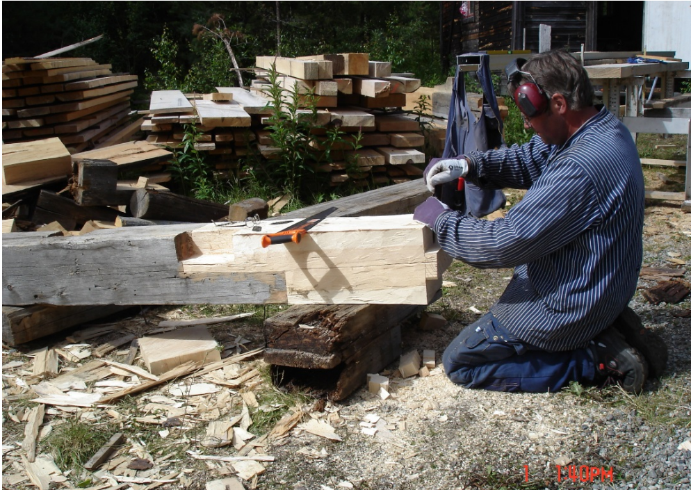
Arbete pågår med stolpe som skarvas i nederkant. Foto Stig Nilsson.
