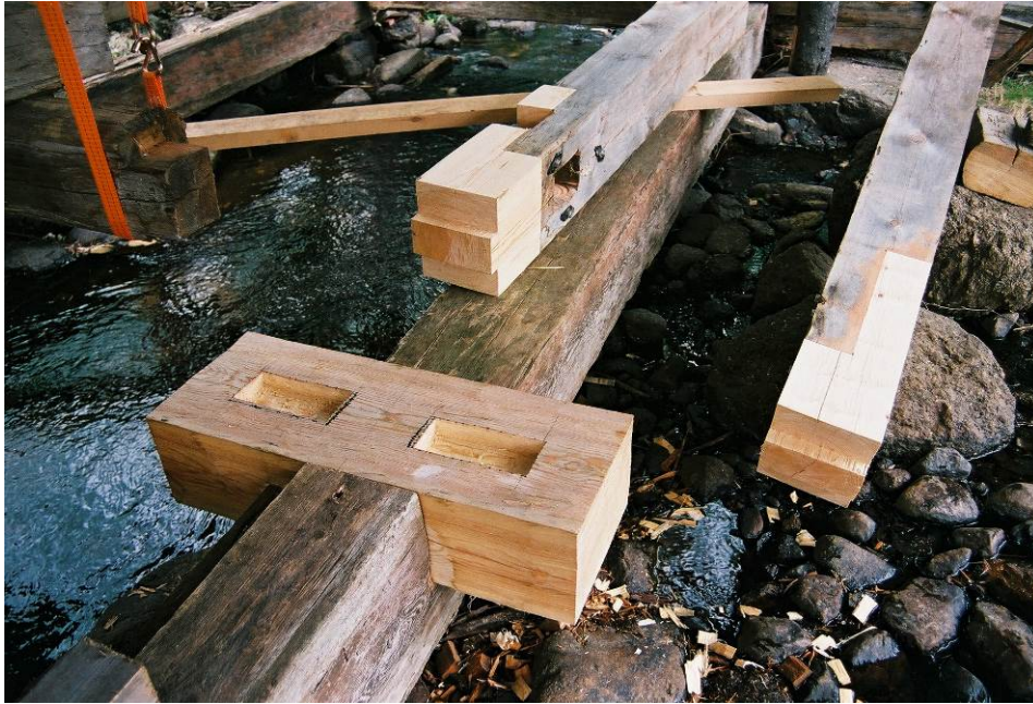
Tvärställda balkar som är infällda i bärlinan (E) har bytts ut. Bildnr: Jlm_08m20_06
