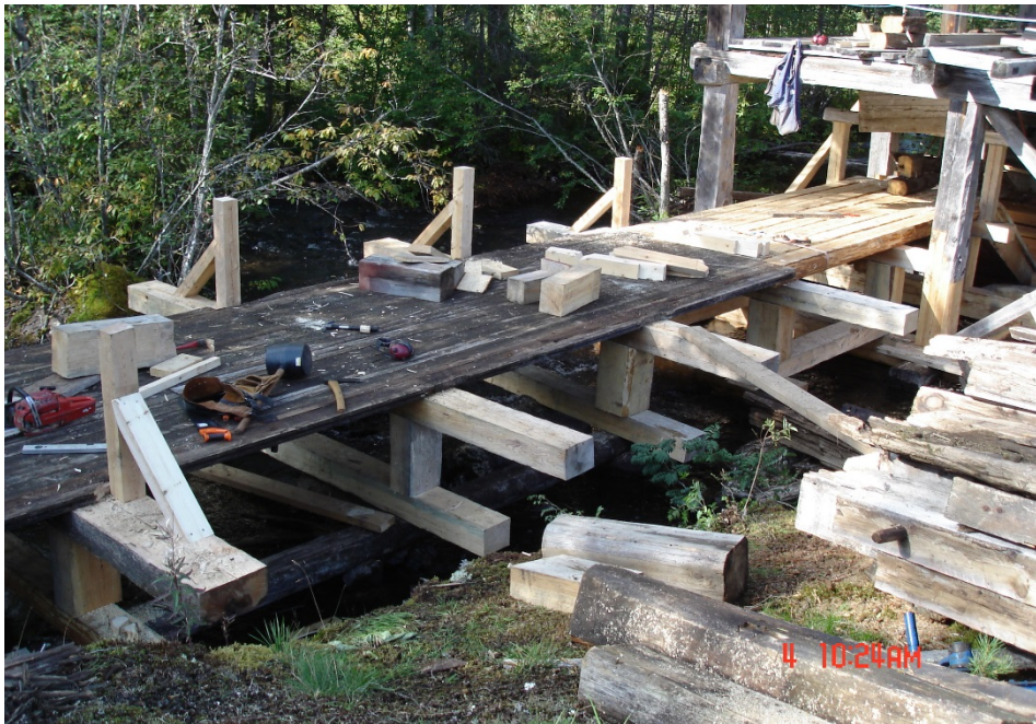
Rännans undre stolpkonstruktion har bytts ut, rännans botten har nytimrats närmst själva sågbyggnaden. Väggarna har demonterats.
