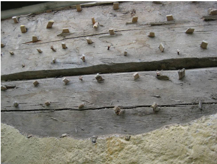
Det fanns träpluggar och smidd spik under lerbruket (digital bild 1711).
