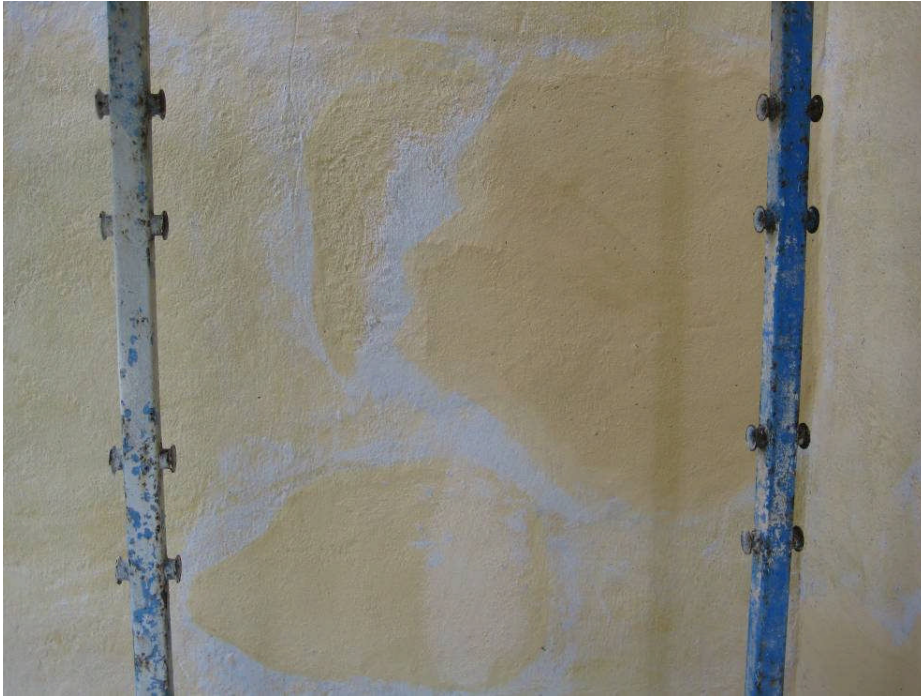
Långhusets västra gavelvägg efter den första avfärgningen (digital bild 1728).
