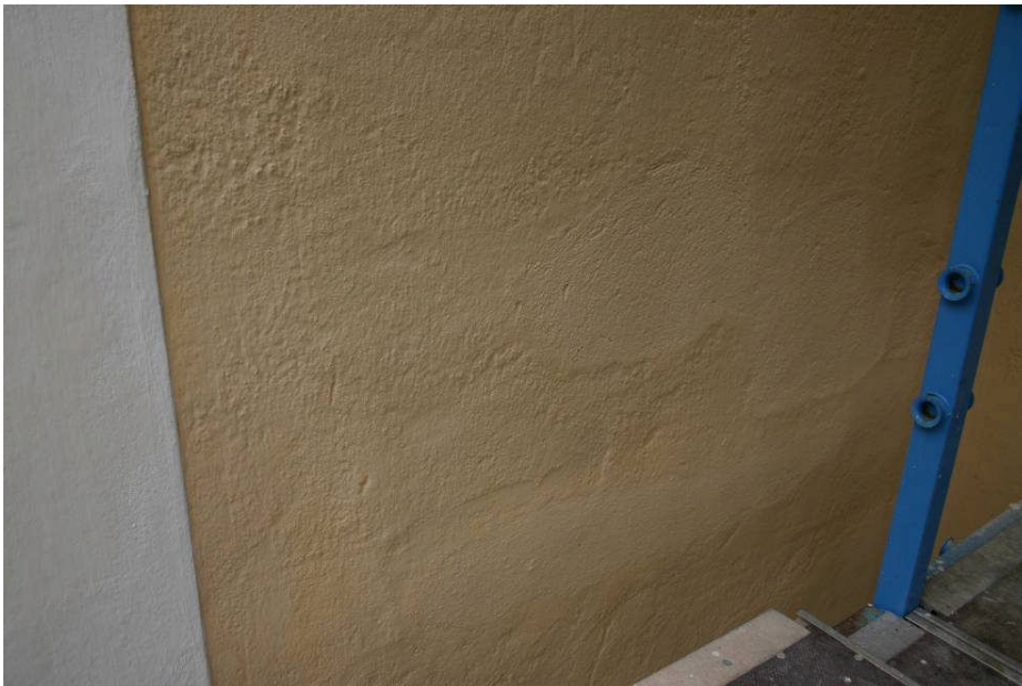
Västra gaveln efter flera avfärgningar. En svag skillnad i kulör finns fortfarande i jämförelse med den äldre putsen som är avfärgad många fler gånger sedan förut (digital bild 0587).
