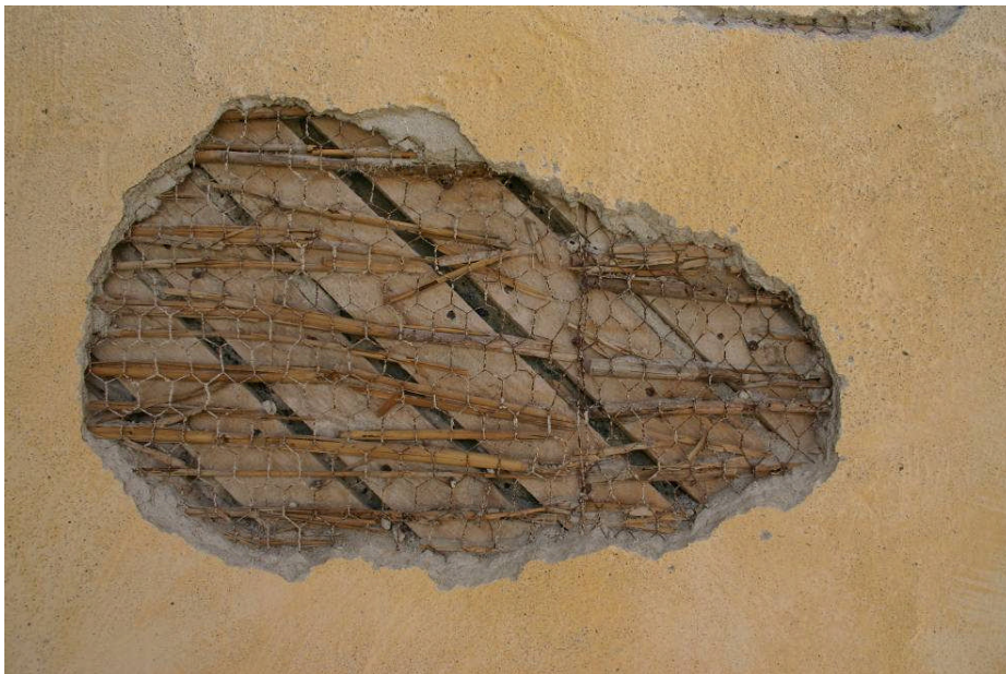
Träribbor, vassmatta och nät på tornets norra fasad (digital bild 0425).
