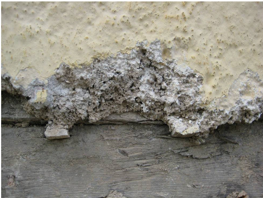
Närbild av lerputsens och den avfärgade kalkade ytan innan restaurering (digital bild 1716).
