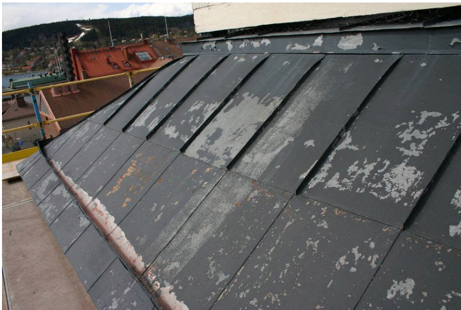
Tornets södra takfall. Färgen flagnade mycket (digital bild 0428).
