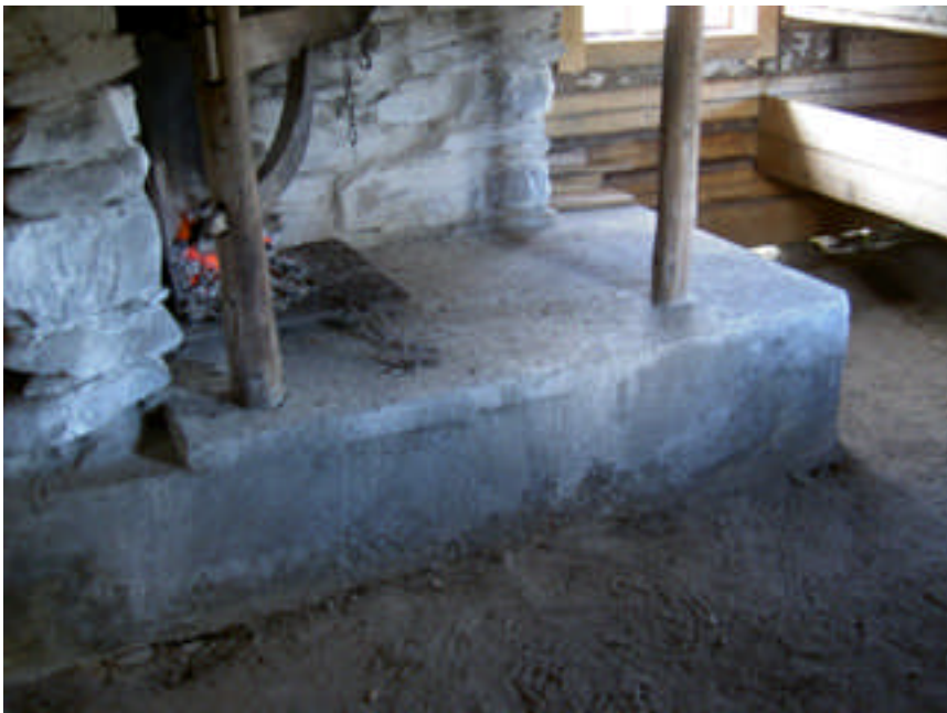
Bild 4: Betonghärden efter lagning.
