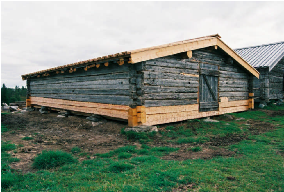
Bild 12: Efter restaurering Fasad A och B.
