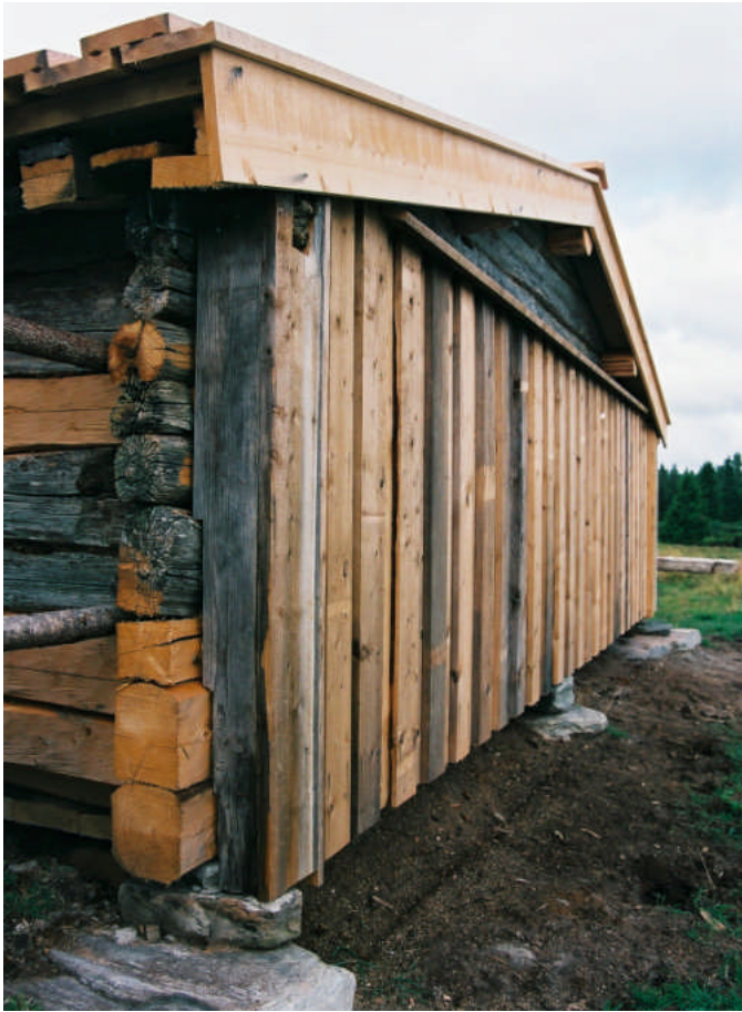
Bild 14: Fasad C efter restaurering.
