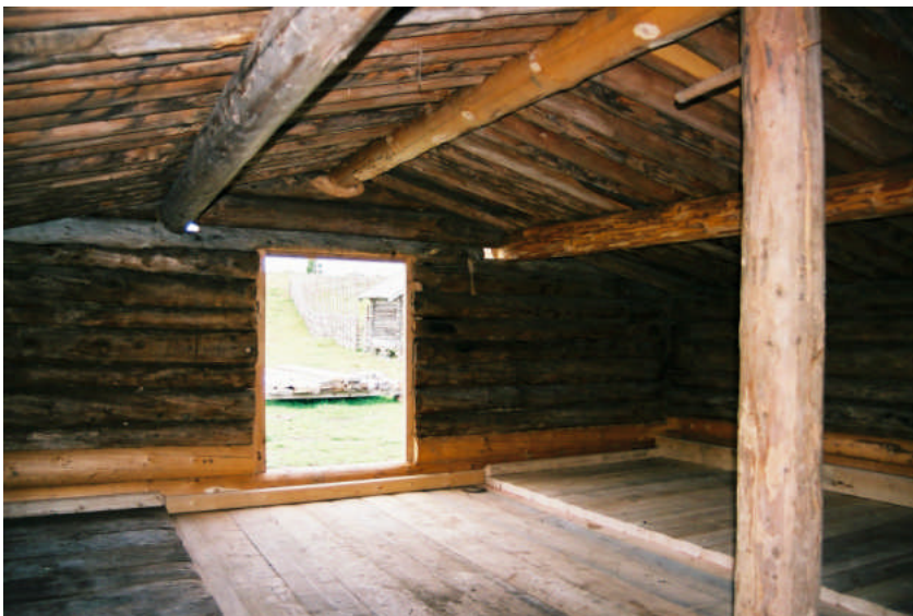
Bild 15: Efter restaurering. Golvet är bytt i mitt och till höger. Äldre delar syns till vänster. Ersatta åsar är avbarkade lika som innan.
