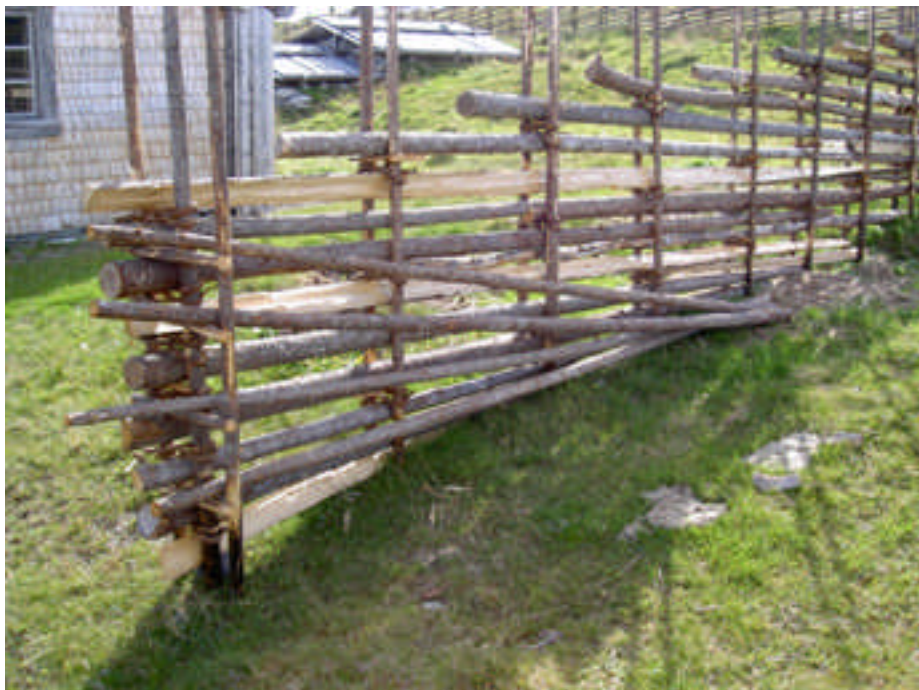
Bild 8: Gärdesgårdens delar tillverkades i gran. Både klyvvet virke och rundvirke förekom.
