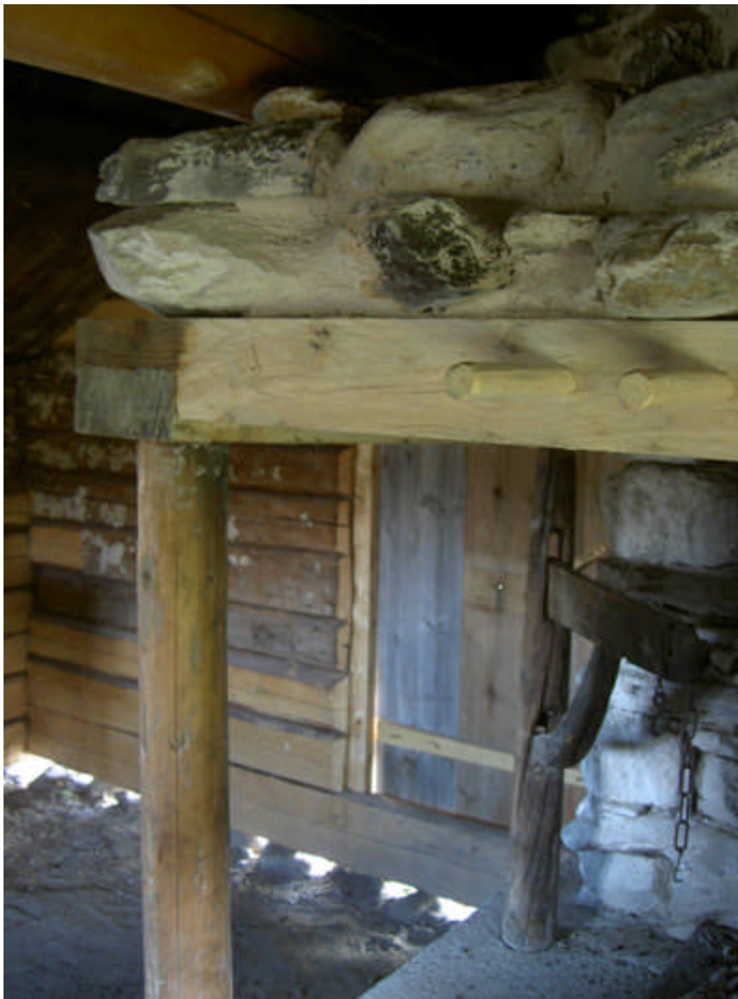
Bild 5: Detalj av bärare efter restaurering.
